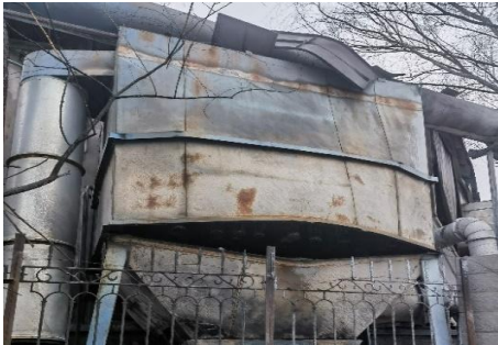
图 3-3 3#湿式除尘器爆炸后现场情况
